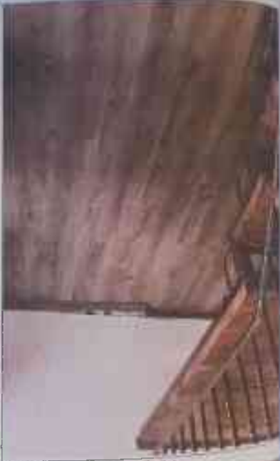
Поддерживание ступенчатого схода с помощью железных стержней
