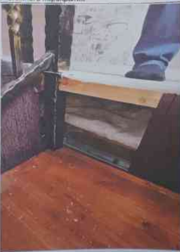
Вскрытие полости межэтажного перекрытия
