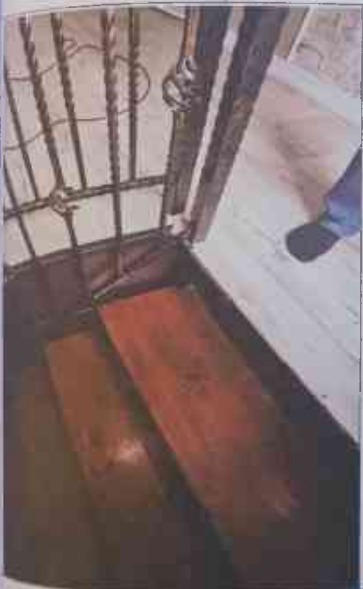
Вскрытие полости межэтажного перекрытия
