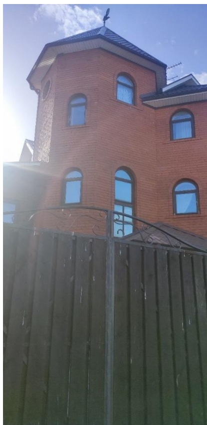
Фотография 4. Фасад дома
